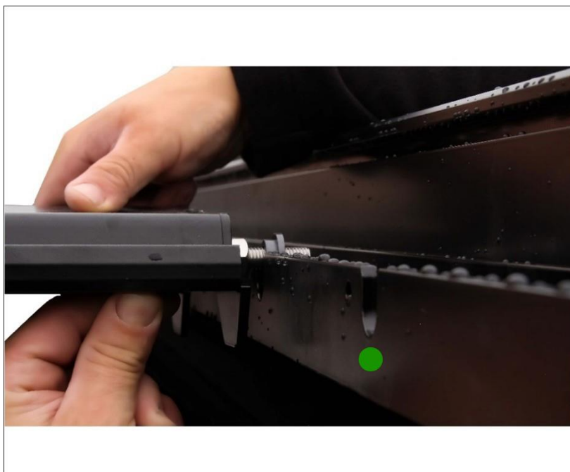
Schritt 9 Setzen Sie die Pergola-Federn ein und denken Sie daran, die Gleitlager auf der Drehachse der Feder zu platzieren (platzieren Sie die Lager auf der Außenseite der Pergola)
